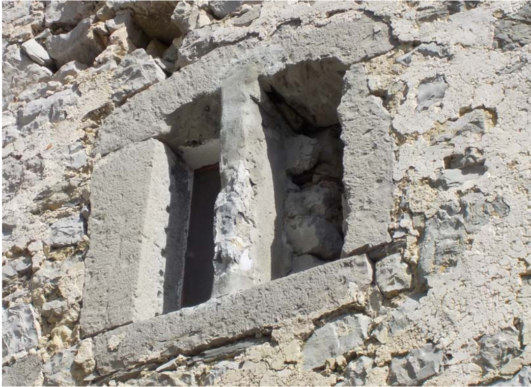
Encadrement de fenêtres en pierre de taille très particulier. Le restaurateur a eu la main plutôt lourde. Pierre sans aucun doute de réemploi.
